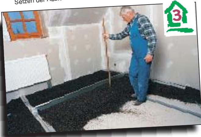
Verdichten der Schüttung ca. alle 4 cm, z. B. mit einem Rechen, Stampfer oder Brettschuhen um ca. 10-15 %.
