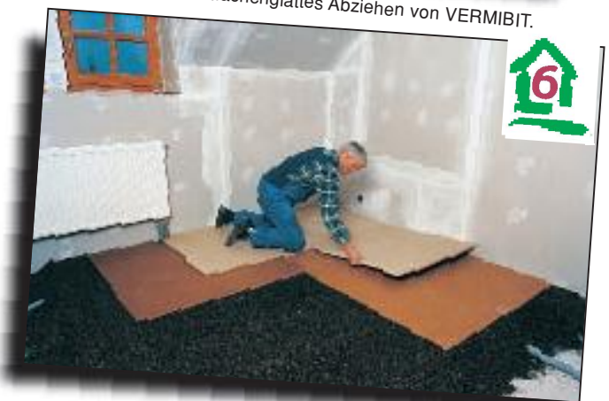
Verlegen der Bodenverlegeplatten von mind. 22 mm Stärke.
