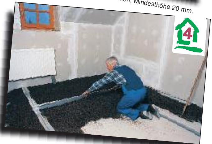
Oberflächenglattes Abziehen von VERMIBIT.
