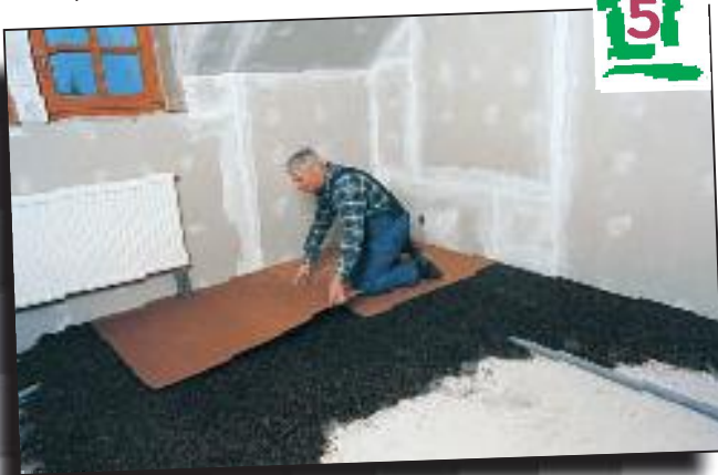
Wellkarton (oder für verbesserten Trittschall Weichfaserplatte 10 mm) verlegt, verhindert das Eindringen der Körner in die Fugen der Bodenverlegeplatten.
