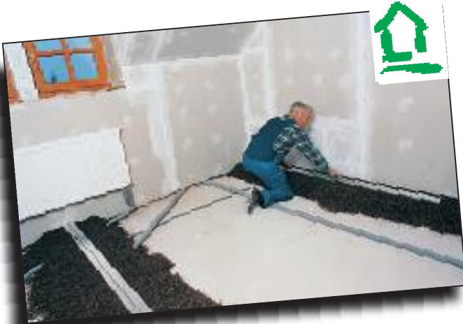
Setzen der Abziehlehren auf z. B. VERMIBIT.
