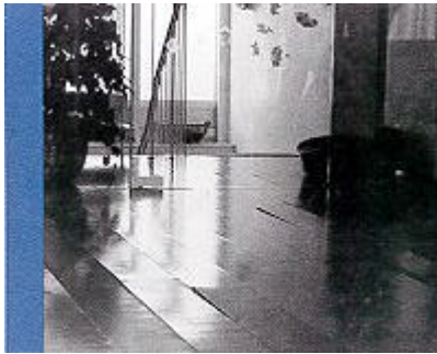
Abbildung 1 Die wellenartige Struktur der Oberfläche des Fertigparketts ist das Ergebnis der Wärmezufuhr durch die Bodenheizung.
